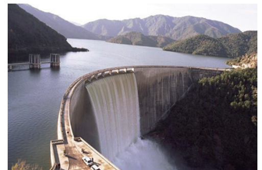
Presa restaurada por la compañía
